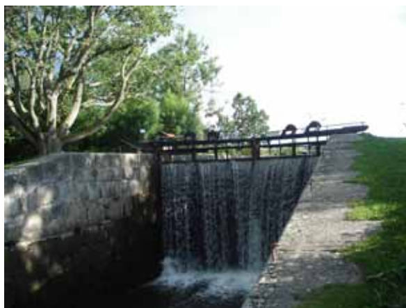
Hjälmare kanal är Sveriges äldsta kanal. Här slussarna vid Graven, kanalens utlopp i Arbogaån
