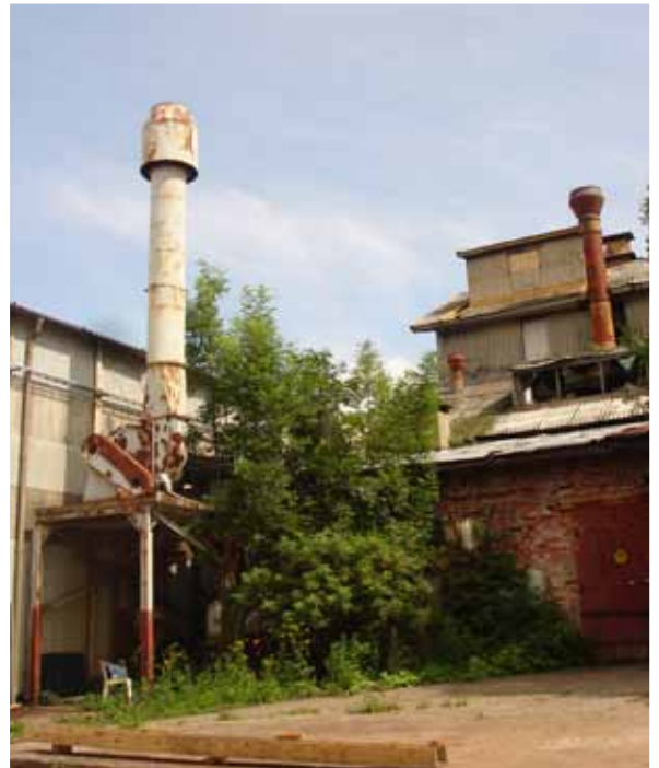
Den gamla industrimiljön vid Arbogas mekaniska verkstad, Meken, förfaller
